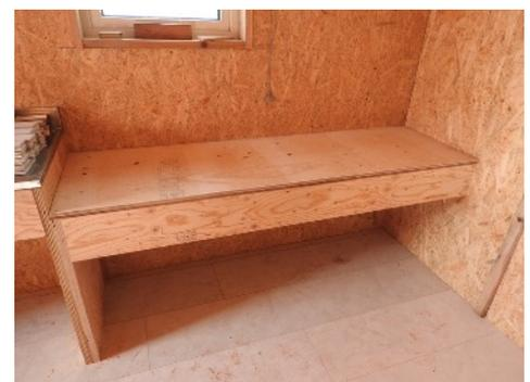
パネに穴を開けて、ぴったり流し台をはめ込んでいきます。右側が調理台で倉庫に置いてあった白いタイルを貼る予定、左側は洗面台で、洗面器を探しています。現場に合わせて手作りの台所・洗面所が出来上がりました。春になったら配管と給水工事を行えば機能的な施設になります。
